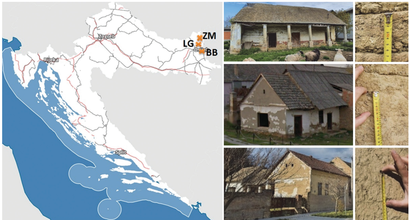
Slika 2. Položaj promatranih kuća na karti Republike Hrvatske (lijevo, preuzeto s [12] i uređeno); Kuća BB i debljina ugrađenog sloja (autorske fotografije, desno gore); Kuća LG i debljina ugrađenog sloja (autorske fotografije, desno sredina); Kuća ZM i debljina ugrađenog sloja (autorske fotografije, desno dolje)
