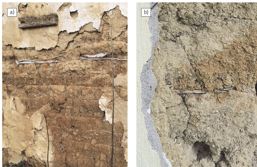
Slika 7. Zidovi od nabijene zemlje s područja istočne Hrvatske uz prikaz organskog materijala između slojeva (autorske fotografije): a) šibla, b) trska i pljeva
